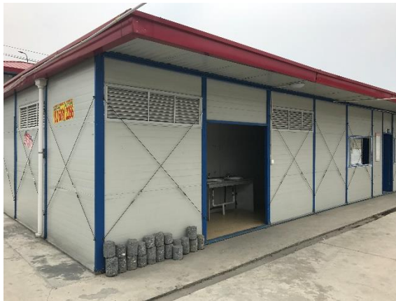
施工营地洗手间
