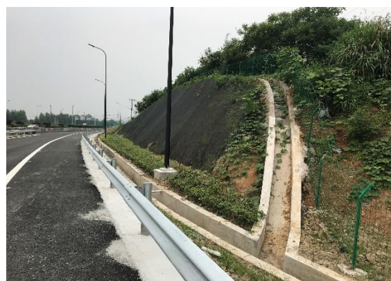
道路沿线绿化及边坡绿化
