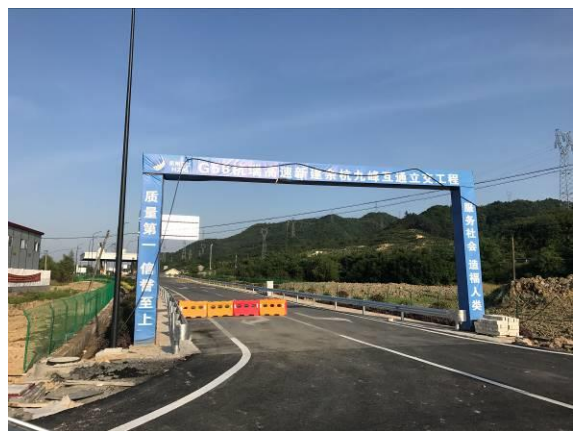
施工场地清理清扫
