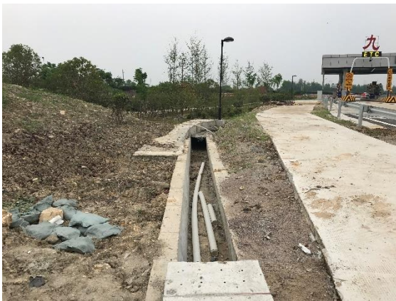
施工场地平整和清理
